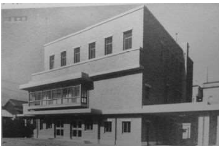
昭和 13 年竣工当時
