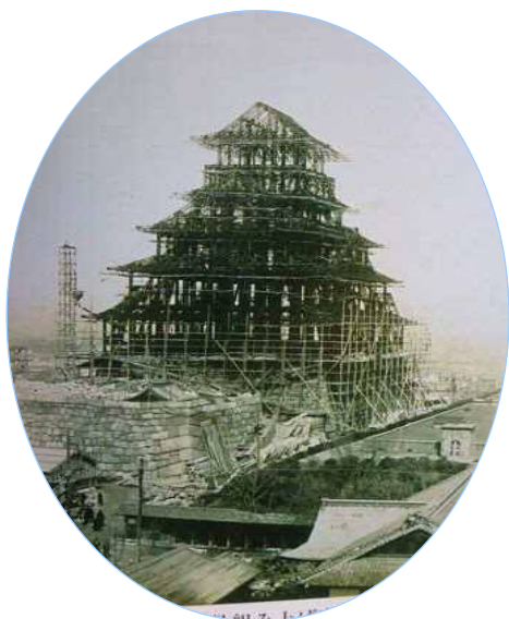
鉄骨組み上げ完了 南東方向より
